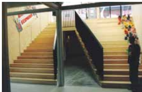
Foto van de tribunetrap naar de 1ste verdieping
